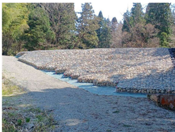
写真1 スマートガビオンの設置状況
